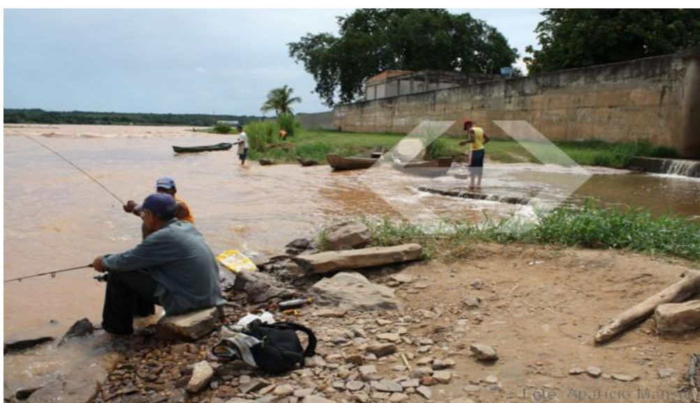
Figura 08 – Pescadores no deságüe poluído do córrego Entre Rios.
