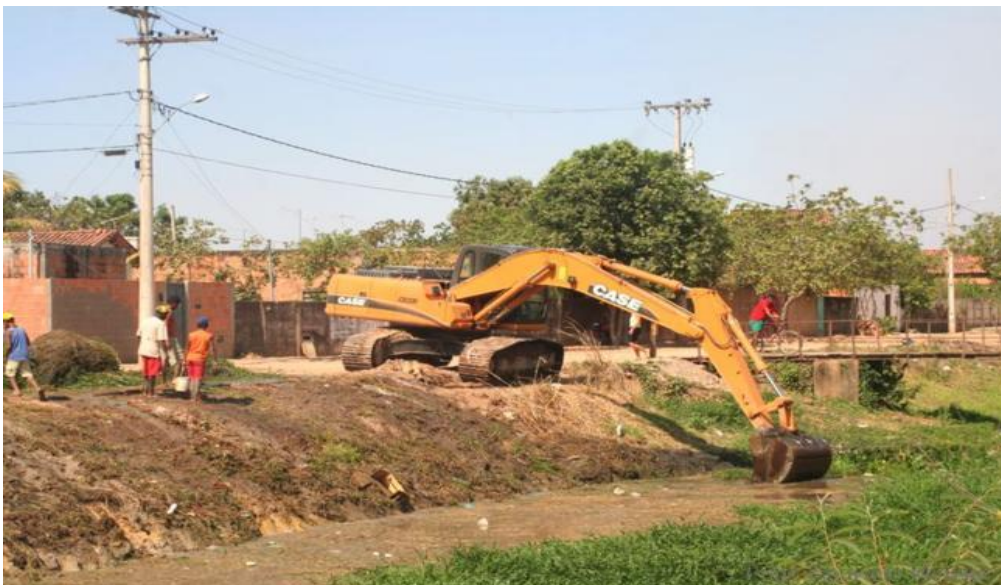
Figura 09 – Máquina da prefeitura fazendo o desassoreamento do córrego Entre Rios.
