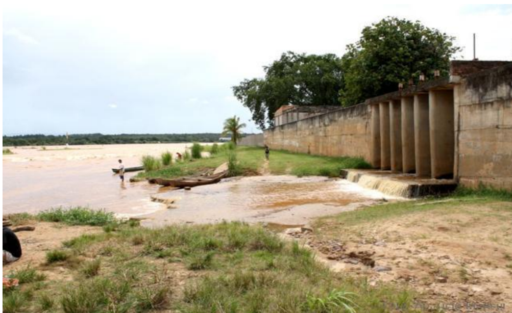
Figura 07 – Comportas por onde deságua o córrego Entre Rios no rio São Francisco.
